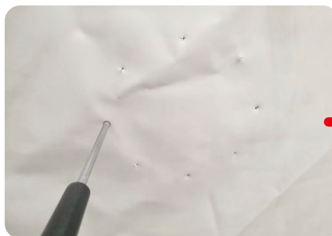
A l'intérieur de la citerne, pré-percer le liner avec un tournevis cruciforme sur les 8 points de fixation du bloc bride inox.
